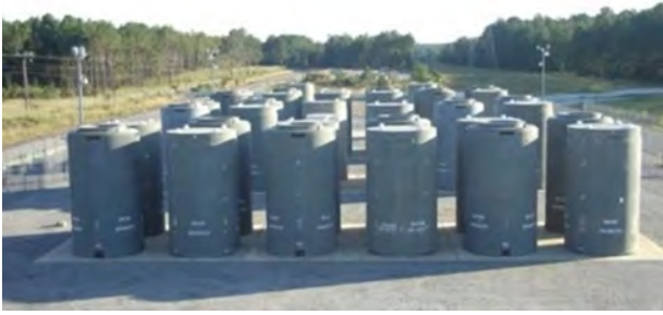
Figura 22: Decantazione secondaria (50-100 anni) di spent fuel in deposito all'aperto [8].
