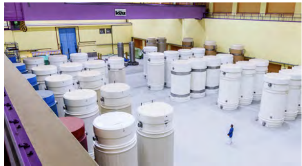
Figura 21: Decantazione secondaria (50-100 anni) di spent fuel in un deposito di Zwiilag [7] (Würenlingen, Zurigo, Svizzera).
