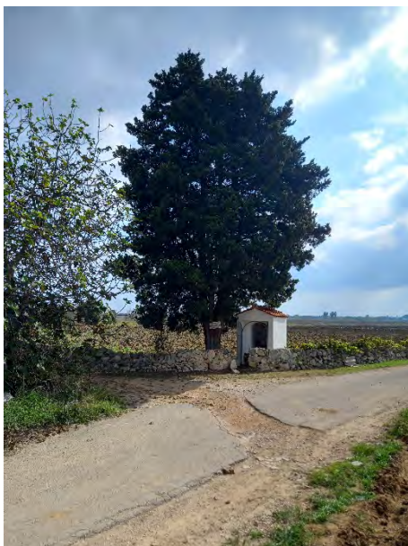
L'oratorio sorge in posizione viaria "semaforica".
